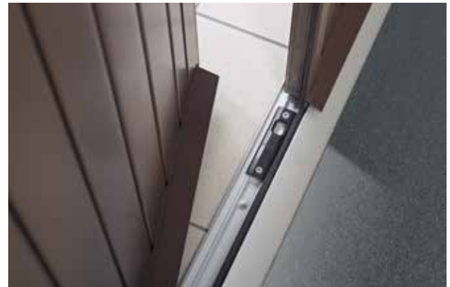
Seuil aluminium standard. Panneau avec jet d'eau filant en partie basse (ouverture intérieure).
