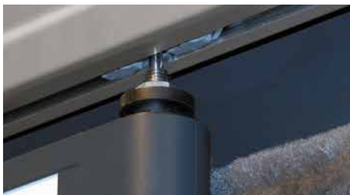
Galet emprisonné sur rail anti-déraillement.
